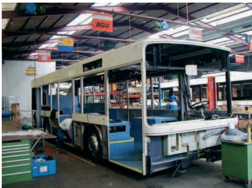
Rohbau: Der Hess-Midi nimmt Form an, der geschraubte Co-Bolt-Wagenkasten aus Aluminium bildet die Basis.
